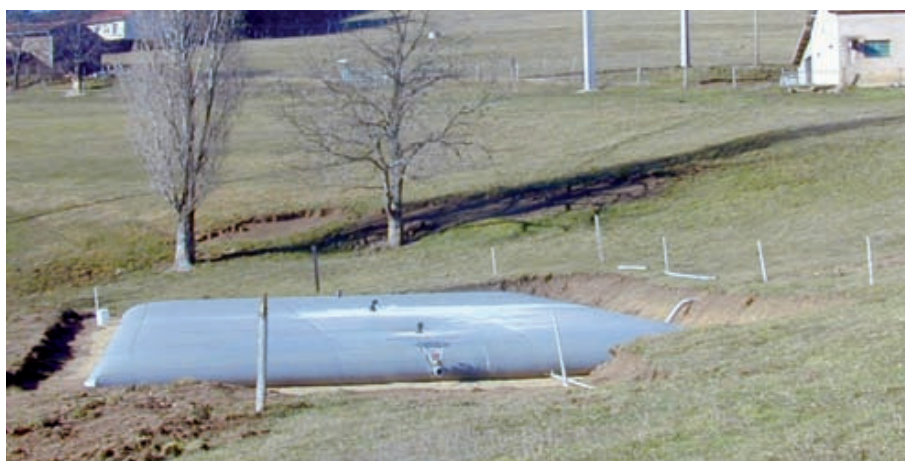
Stockage d'eaux blanches
